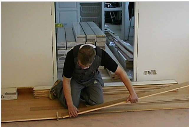
Paigalda teine paigaldustugi järgmisele lauale sarnaselt eelnevaga. Kui teine paigaldustugi on kinnitatud, eemalda esimene tugi. Jätka sarnaselt kuni lauarivi on paigaldatud.
