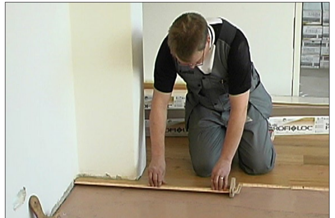
Paigalda laud toe abil põrandale sarnaselt ujuvpõranda paigaldusele. Paigaldustugi hoiab laua õiges asendis ning ei lase liimil valguda parketilaua pinnale.
